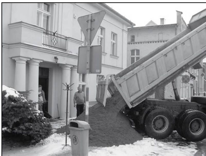
Remont w muzeum – przybył transport betonu.
