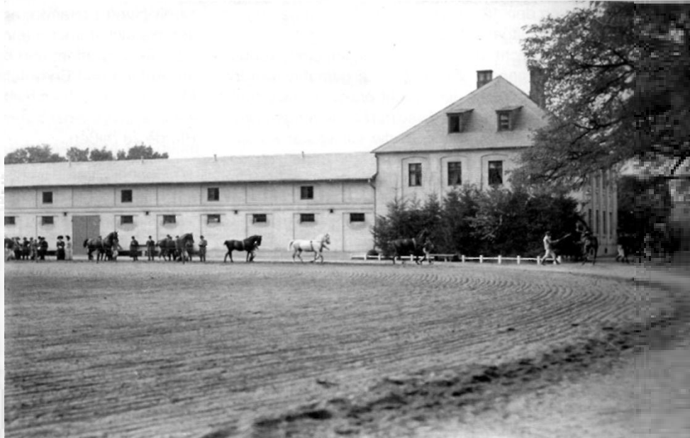
Neuer Stall mit Wohnungsanbau am Reitplatz vor 1919
