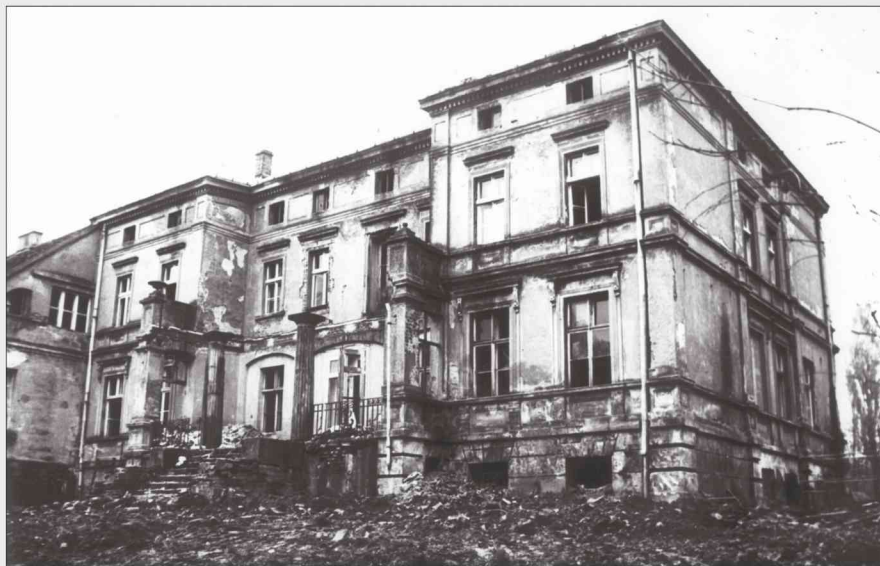
Białokosz. Widok zniszczonego dworu pod koniec II wojny światowej. Fotografia z 1945 r.
