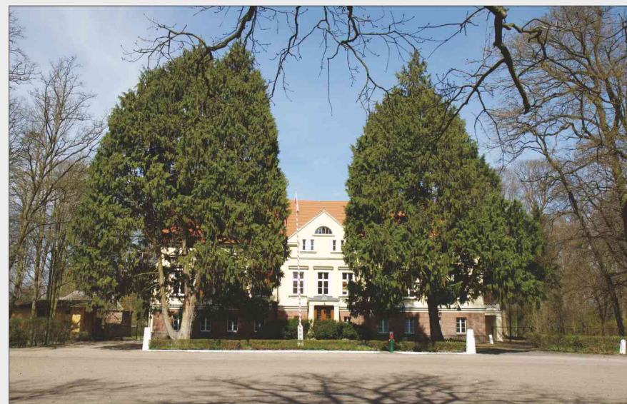
Sieraków. Pałac w Stadzie Ogierów od strony frontowej. Fotografia z 2011 r.
