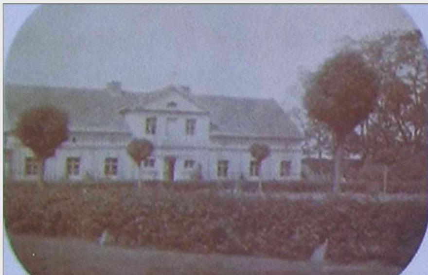
Kwilcz. Północna oficyna dworska przed przebudową. Fotografia, koniec XIX w. Źródło: A. Kwilecki. „Kwilcz i inne majątki Kwileckich na przestrzeni wieków”. Poznań 1996 r.
