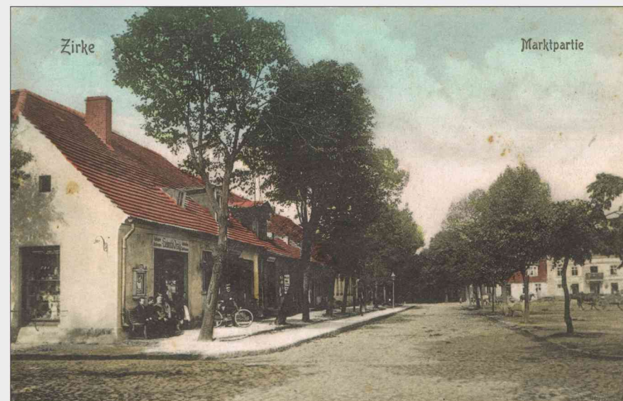
Sieraków. Rynek, narożnik południowo-zachodni z widoczną zabudową. Karta pocztowa, wyd. Heinrich Ossig, Sieraków, 1907 r.
