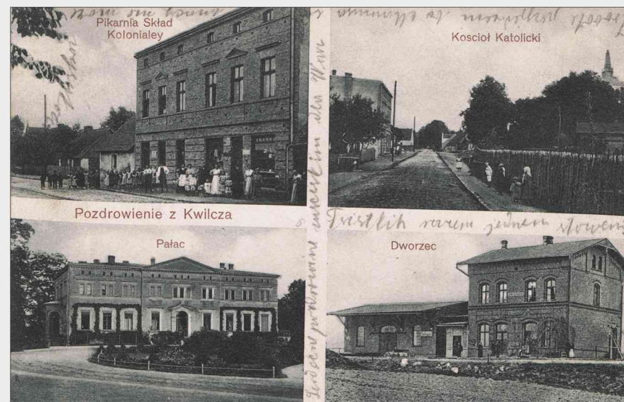
Kwilcz. U góry: po lewej widoczna piekarnia i sklep kolonialny J. Cieplińskiego, po prawej ulica Wiejska i kościół katolicki. U dołu: po lewej pałac, po prawej dworzec kolejowy. Karta pocztowa, wyd. R. Brock, Berlin, 1908 r.
