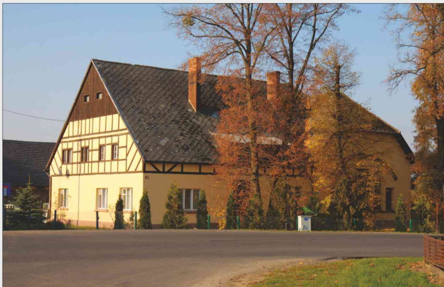
Grobia. Dawna gospoda, obecnie dom mieszkalny. Fotografia z 2011 r.
