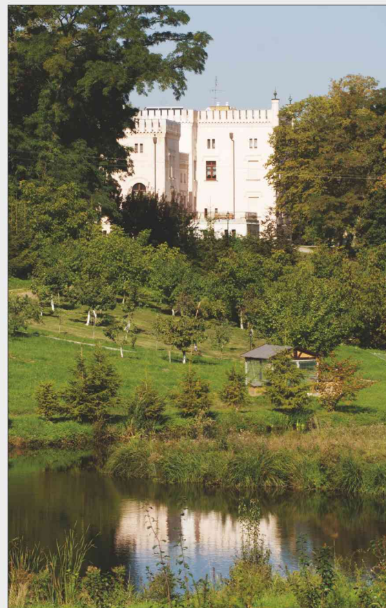
Śródka. Widok pałacu od strony ogrodu. Fotografia z 2011 r.
