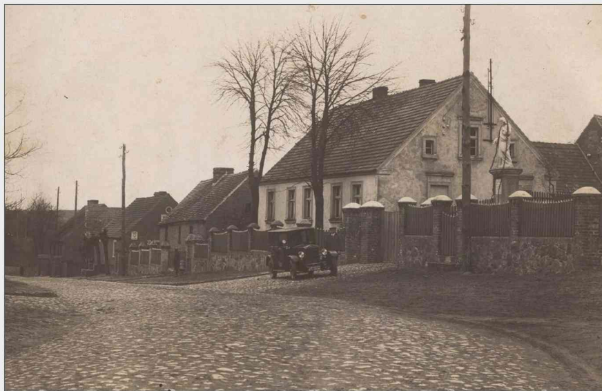
Dormowo. Widok głównej ulicy wsi. Fot. ok. 1920 r.
