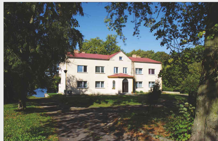
Gorzyn. Widok dworu w Gorzynie od strony frontowej. Fotografia z 2011 r.
