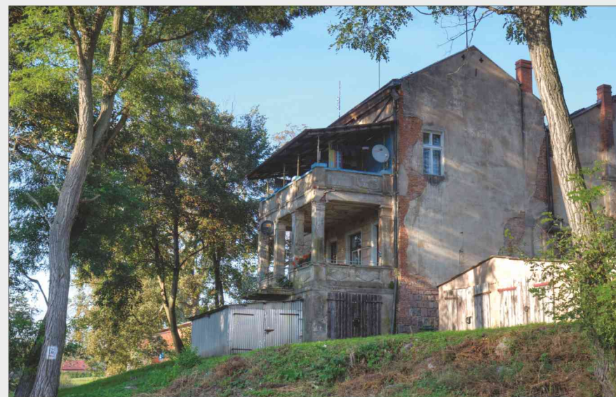
Mniszki. Dwór, tzw. nowe skrzydło od strony zachodniej. Fotografia z 2011 r.
